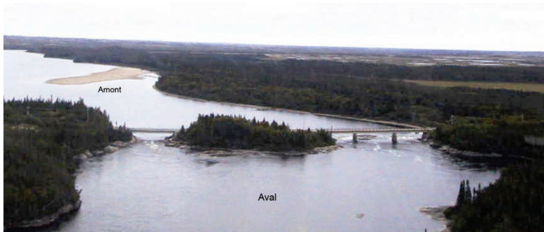
Photo QC-179-1 : Rivière Romaine au pont de la route 138 (PK 2,25) – Débit de 164 m 3 /s
