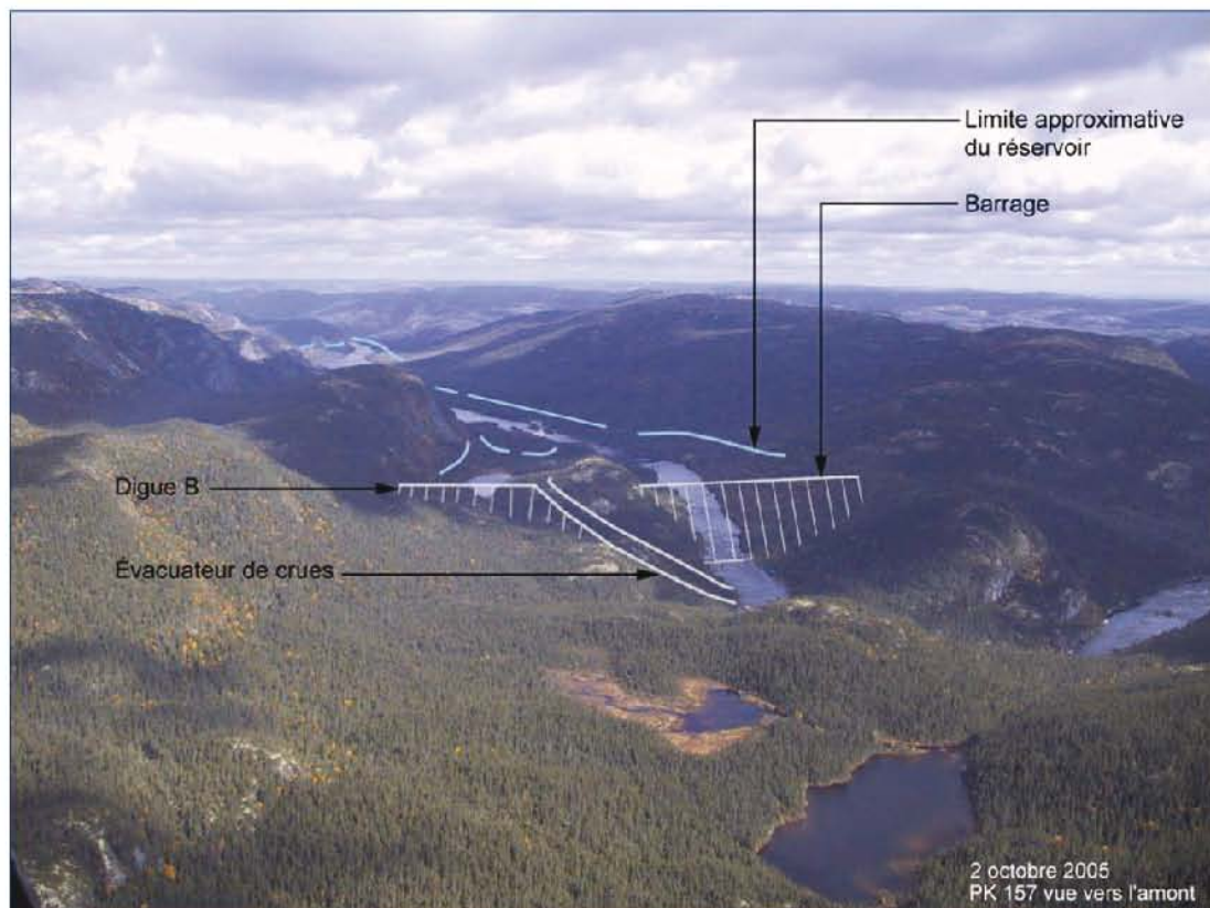
Photo QC-180-15 : Emplacement des ouvrages de la Romaine-3
