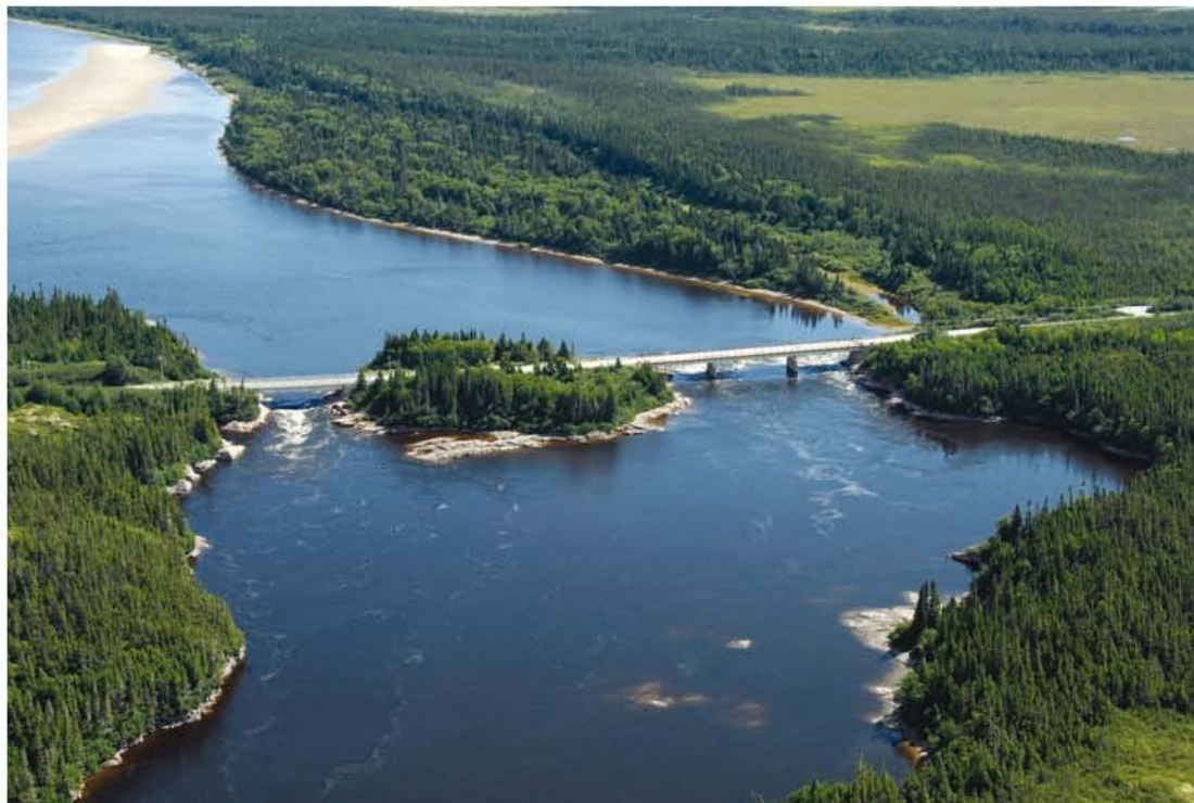
Photo QC-179-2 : Rivière Romaine au pont de la route 138 (PK 2,25) – Débit de 225 m 3 /s
