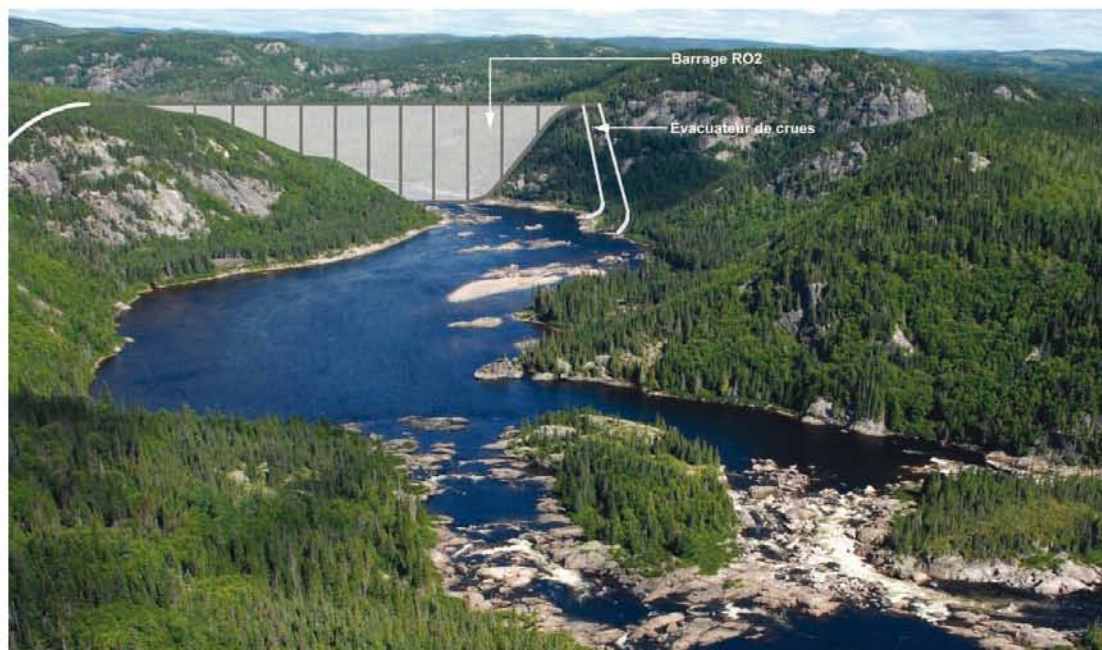
Photo QC-180-8 : Emplacement des ouvrages de la Romaine-2
